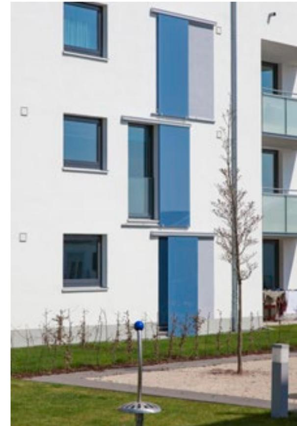
**Ausführung** 177 einflügelige und 24 doppelflügelige elektrische Schiebeläden mit unterer Führungsschiene
