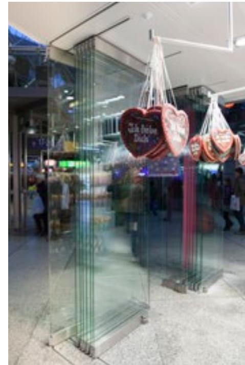
Ausführung HSW Anlagen Reihe 700 / 8 Pendel-Endflügel / 24 Schiebeflügel / 4 Parktaschen
