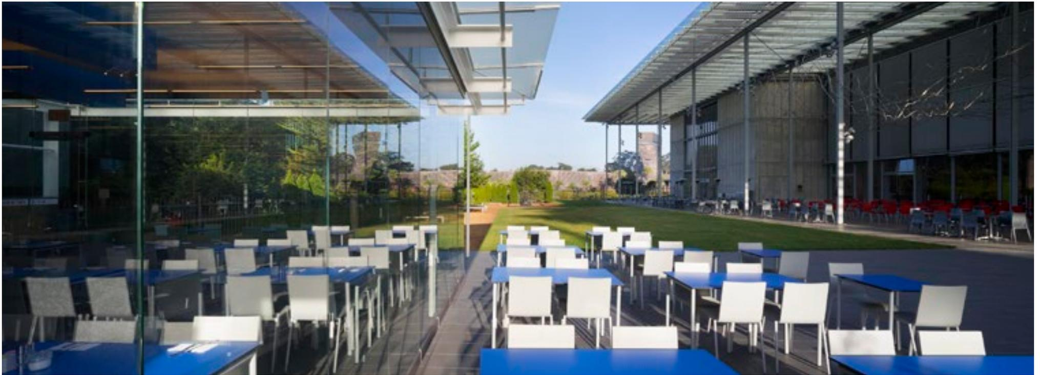
**Ausführung** 2 Anlagen HSW Reihe 750 — Anlage 1: 10 Schiebeflügel, 1 Pendelschiebeflügel mit Oberlicht, 1 Pendelendflügel / Anlage 2: 8 Schiebeflügel, 1 Pendelschiebeflügel mit Oberlicht, 1 Pendelendflügel **Oberfläche** Türschielen: Niro matt gebürstet; Park-Laufkonstruktion: E2/ C31 Niro ähnlich eloxiert **Glas** VSG 16,5 mm Ornilux (Vogelschutzglas)
