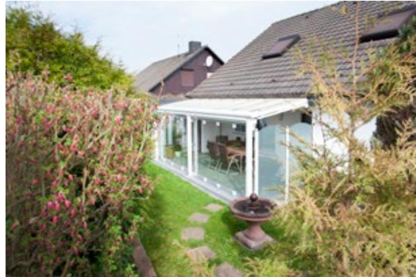
Ausführung 2 Faltanlagen Reihe 500 mit je 4 Flügeln Oberfläche RAL 9016 (Verkehrsweiß) Glas ESG 8 mm
