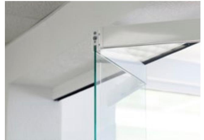
Ausführung 5-flügelige Falanlage Reihe 100 mit oberen und unteren Türschiene, Griffmuscheln und Bürstenprofil in Laufschiene Oberfläche RAL 9016 Glas ESG 10 mm
