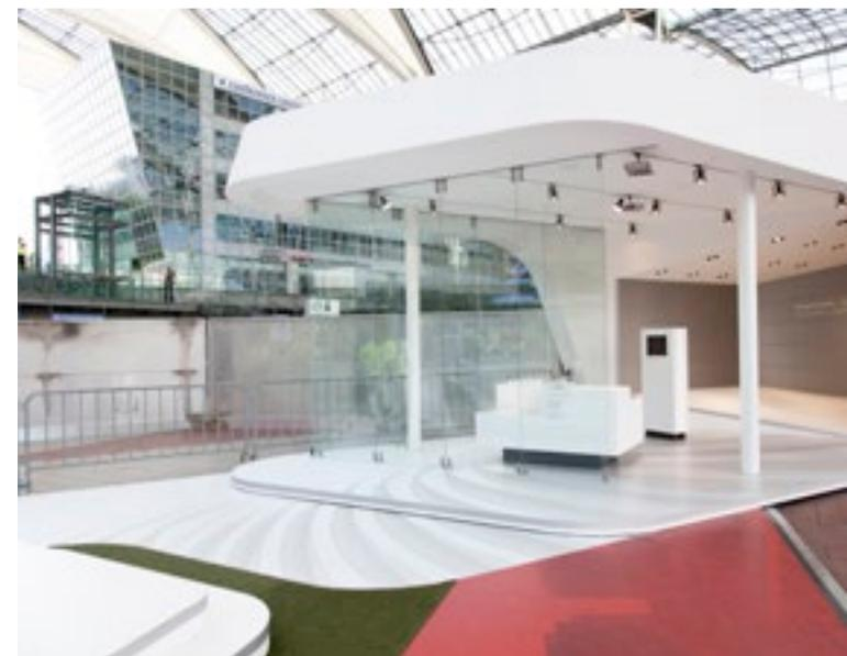
Ausführung 30-tlg. HSW-Anlagen PUNKTO Reihe 750 Oberfläche Laufschiene E6/EV1 eloxiert Oberfläche Beschlag Niro matt gebürstet, Korn 320 Glas ESG 10 mm
