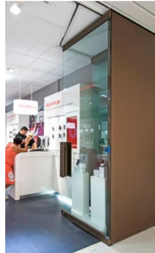
Ausführung diverse HSW-Anlagen Reihe 700    Oberfläche Laufschiene E2/C35 eloxiert (Schwarz)    Oberfläche Beschlag E2/C35 eloxiert (Schwarz)    Glas ESG 10 mm
