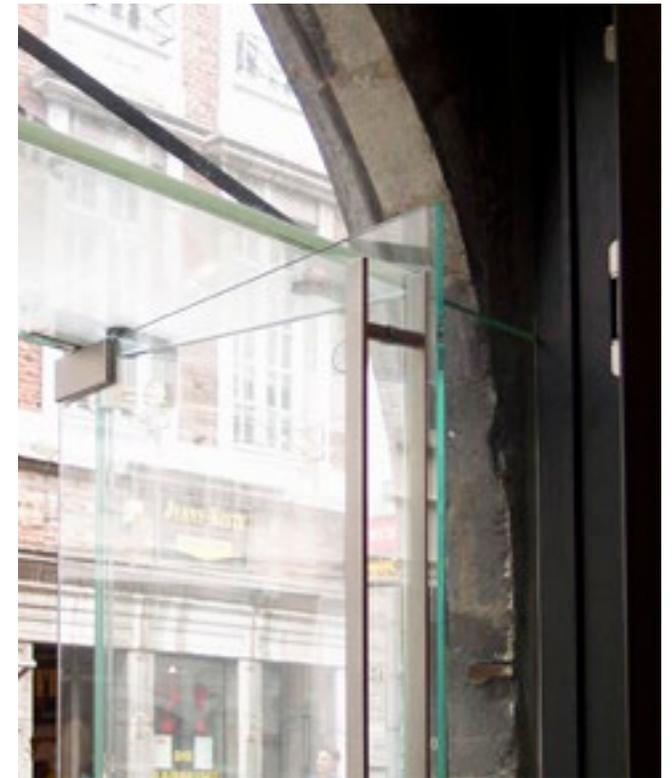
**Ausführung** 2-flügelige Pendeltüre mit Türschienen unten und Universalbeschlag JUMBO oben (PT 20 und PT 40)
